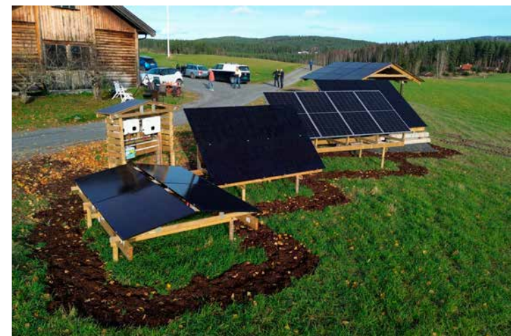
Visningsanlegg ved Skollenborg, Kongsberg. Fem ulike konfigurasjoner av rammer for bakkemontert solceller, basert på trevirke.
