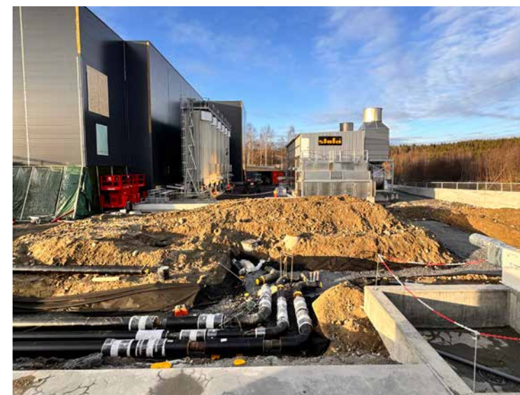
Bygging av VGM Operatørs biokarbonfabrikk på Follum.
